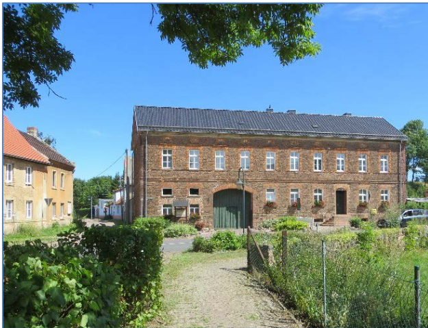
Kaltenmark, Ortsbildprägendes Gebäude
