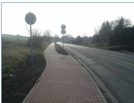
Radweg entlang der L145 (Ortslage Teicha)
